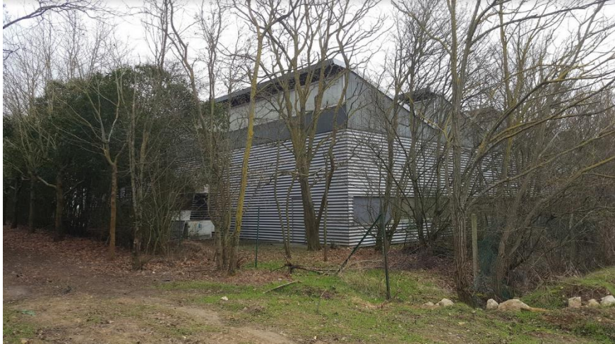
Photo 5 : Vue de l'extérieur du site depuis le Nord-Ouest
