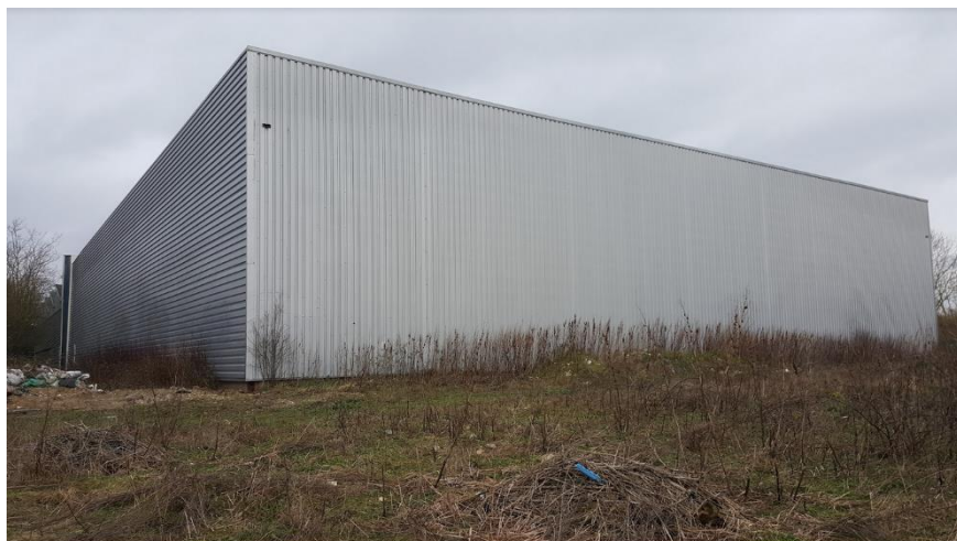
Photo 4 : Vue de l'extérieur du site depuis le Sud-Ouest au niveau de la zone projet
