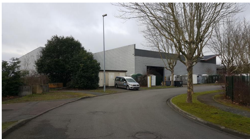
Photo 3 : Vue de l'extérieur du site depuis le Sud-Est (rue R. Panhard E. Levassor)
